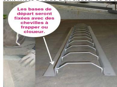
Au moment du coulage des fondations, l'utilisateur du système aura pris soin de disposer les attentes nécessaires dimensionnées par le bureau d'étude structure de l'opération.
