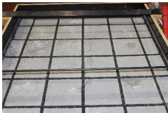
Matériau de jointoiement mis en place
