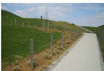
Ce sable stabilisé offre **l'aspect d'un sol naturel**. Pratique, il limite les poussières par temps chaud et les boues en cas de pluie. Sa mise en œuvre nécessite un nivellement soigné par finisseur, règle ou raclette en respectant l'écoulement normal des eaux de pluie.
