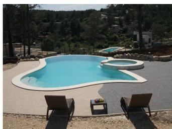
Breveté par la société VM BÉTON SERVICES, ce système conjugue les avantages d'un **béton drainant** à ceux d'une **résine décorative** liée à des granulats sélectionnés. Il permet de réaliser des sols décoratifs extérieurs **pour les descentes de garage, parvis, plages de piscine...** Constitué d'une dalle en béton drainante, il **hydrate naturellement les sols et laisse s'infiltrer l'eau de surface**. Un gage de sécurité !
