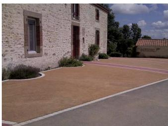
Ce **béton monogranulaire** de porosité importante peut être coloré dans la masse ou minéralisé en surface. Le fond de forme requiert une préparation spécifique : soit une pente adéquate, soit un système de drainage permettant l'évacuation des eaux de ruissellement. Cette solution est avantageuse grâce à sa **capacité d'absorption des eaux pluviales et des bruits**
