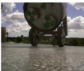
Ce béton peut **être mélangé de plusieurs types de granulats, être coloré ou rester à l'état naturel**. Il est érodé en surface grâce à un polissage mécanique qui laisse apparaître les effets du squelette granulaire. Le polissage offre une surface plus ou moins lisse, définie selon l'application, intérieure ou extérieure.
