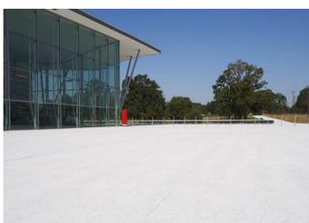
Dédié aux environnements extérieurs, ce béton peut être coloré. Il est composé de **granulats locaux spécifiques** sélectionnés pour leurs qualités esthétiques et rendus visibles par l'érosion de surface grâce à un processus de bouchardage mécanique. Sa **surface rugueuse** laisse apparaître les variations du squelette granulaire.
