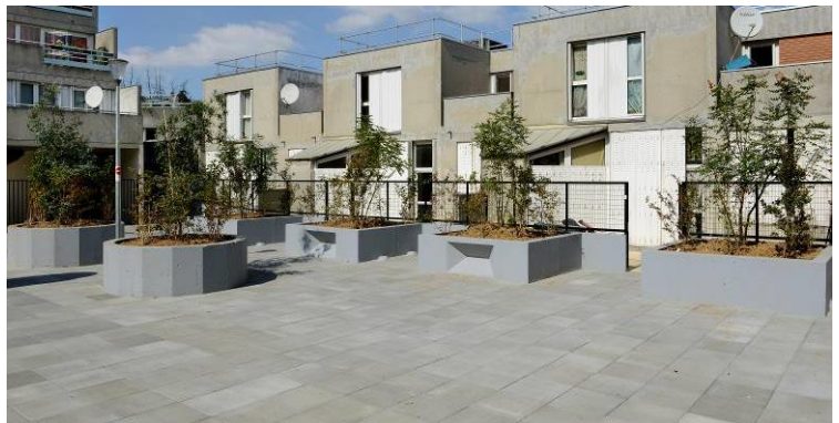
Toiture terrasse Dalle étancheur ALLEGO® Crédit photo : Armand Sarlangue
