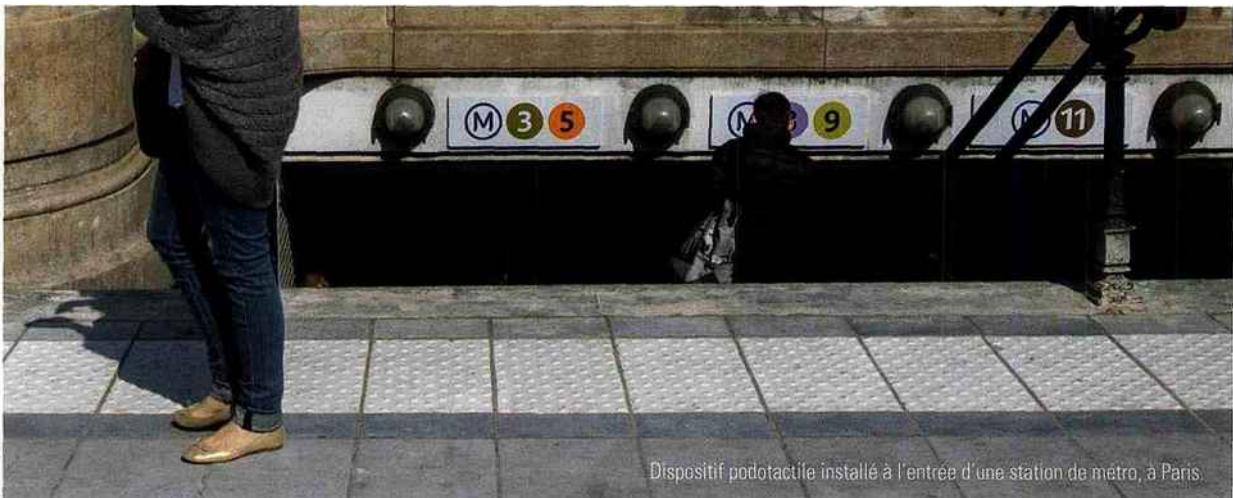
Dispositif podotactile installé à l'entrée d'une station de metro, à Paris.
